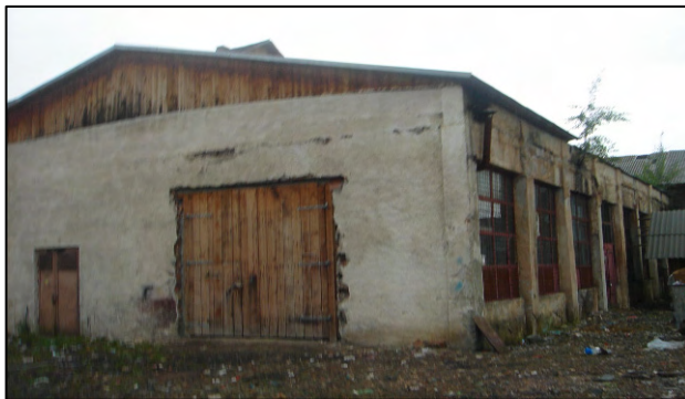
Abbildung 3: Ehemalige Übergabestation. Standort für Heizwerk.
