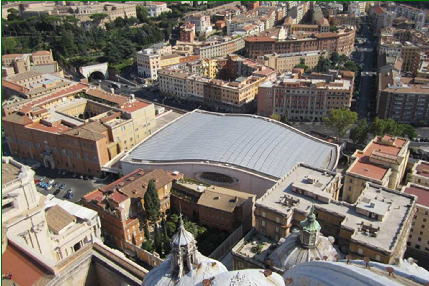
Fotovoltaik Audienzhalle, Vatikan
