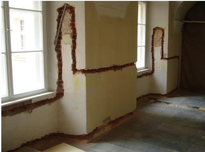
Bauteilheizung: Rohrführung und Verteiler
