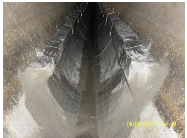
Abbildung 1: Kanalwärmetauscher, Quelle: Stadtwerke Amstetten
