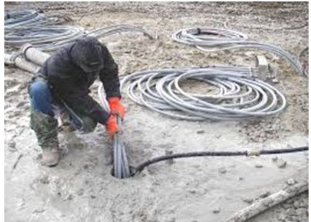
Foto: Solites; Steinbeis Forschungsinstitut für solare und zukunftsfähige thermische Energiesysteme
