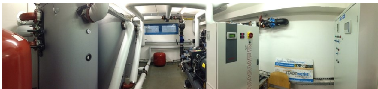
Abbildung 3: Heizzentrale mit Wärmepumpe (Quelle: Kanalabwasser) in Amstetten | Foto: Ochsner Wärmepumpen GmbH.
